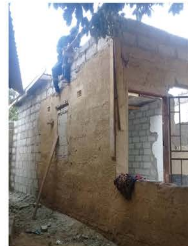
屋根設置まで進みました。予算上、安いトタン屋根になったので、いづれしっかりしたものに変わりたいと考えています。
