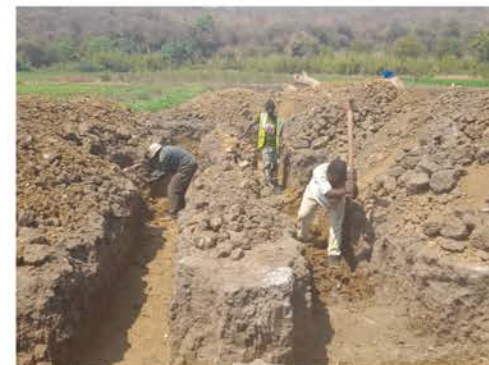
中高等学校建設の様子
