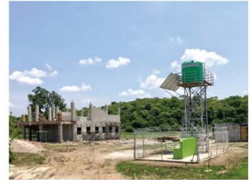
建設中の中高等学校。奥に、購入希望の土地がある。
