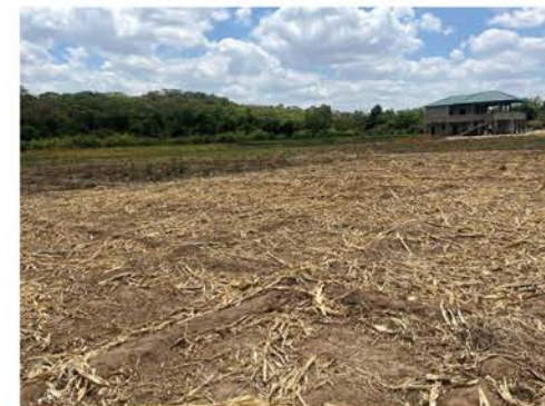
建設中の学校と周辺の土地
